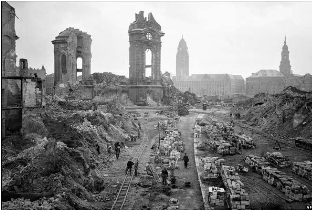
Dresde.- Edificios y calles atestados de refugiados civiles quedaron bajo fuego convertidos en ruinas llenas de cadáveres
